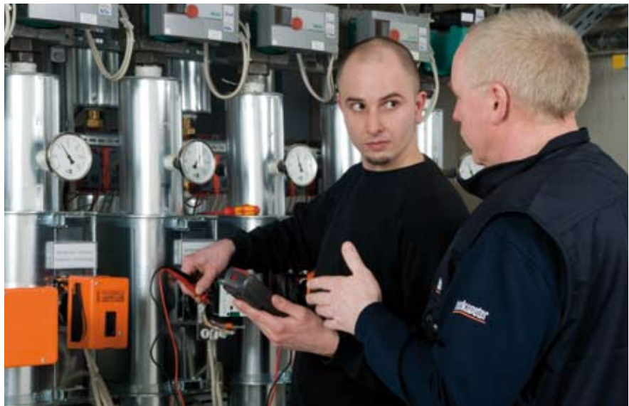
Wartungsarbeiten an einem Heizkreis-Verteiler
